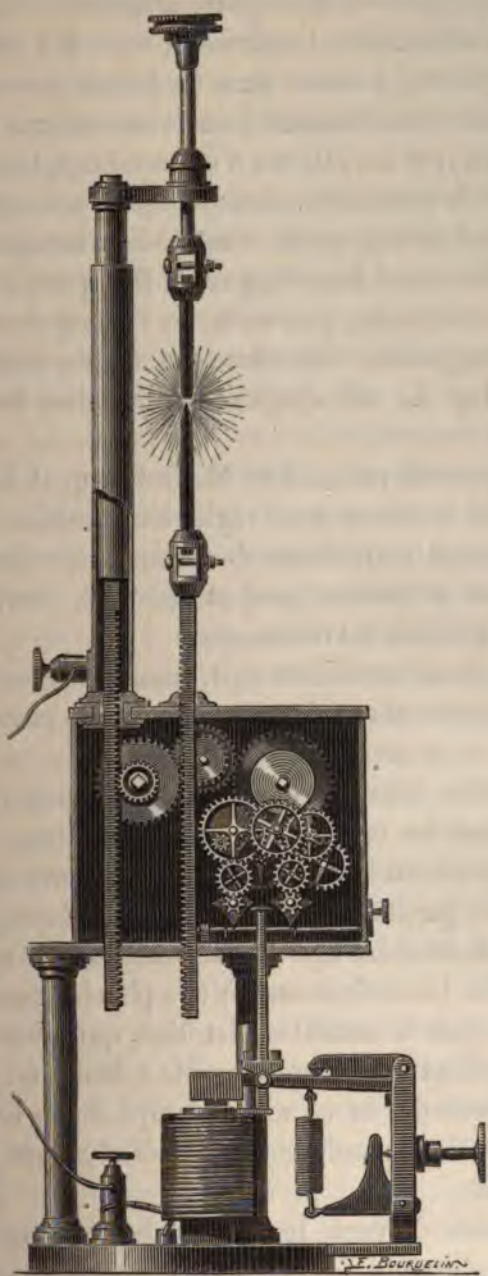
FIG. 14. Régulateur Foucault et Duboscq.
